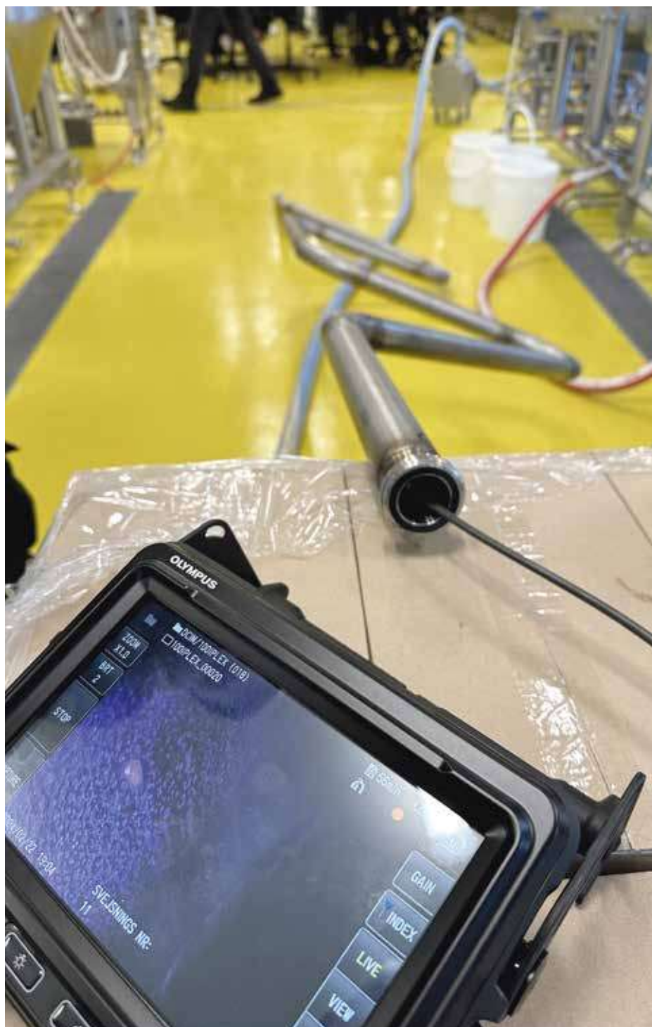
Billede 4. Rengørighedstest af den håndvejste rørkonstruktion, hvor der foretages endoskopi med UV-lys.
